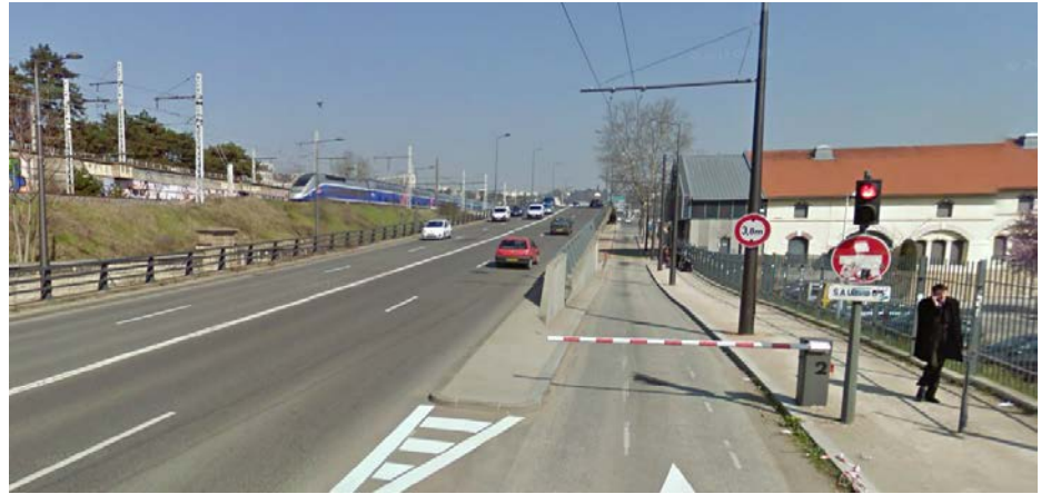
Figure 20 : le viaduc du Boulevard de Stalingrad
